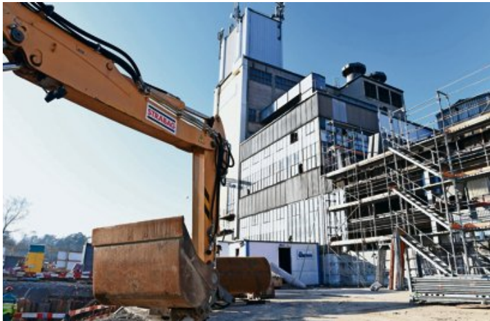
Läuft alles nach Plan, dauert der Rückbau der alten Gebäude auf dem Bülachguss-Areal noch rund ein halbes Jahr.
