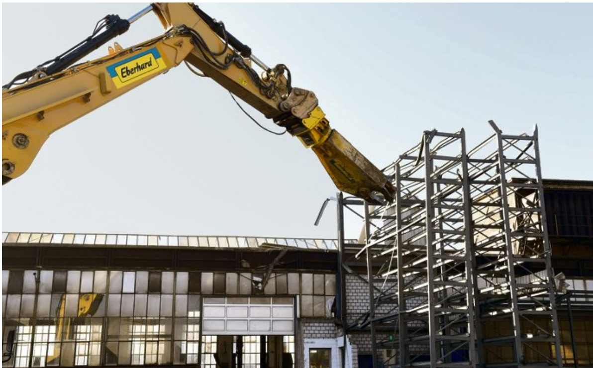
Für eine neue Siedlung mit 490 Wohnungen sowie Gewerbe- und Büroflächen müssen die alten Bauten auf dem Gussareal in Bülachs Norden weichen.
