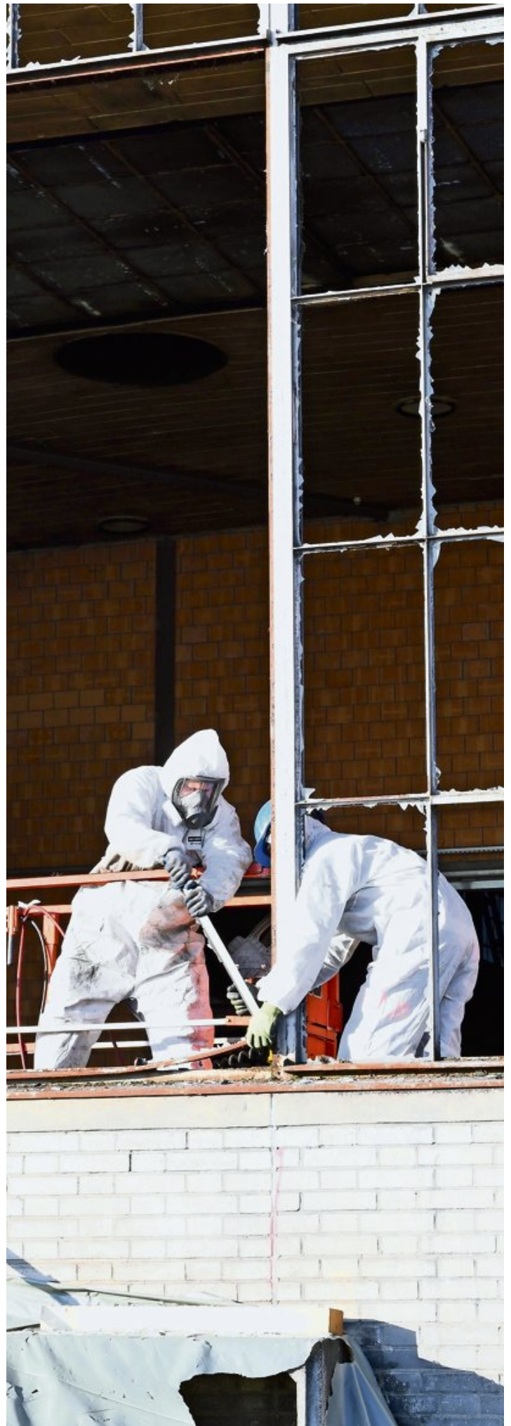
Eingepackt in Schutzanzüge, entfernen Spezialisten die asbesthaltigen Platten.
